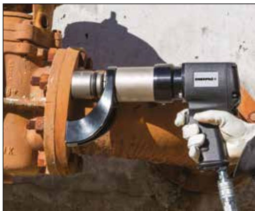
◀ L'attrezzo PTW1000 esegue rapidamente la manutenzione di questa flangia.
